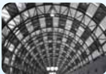
터널, 공항의 조명설비
